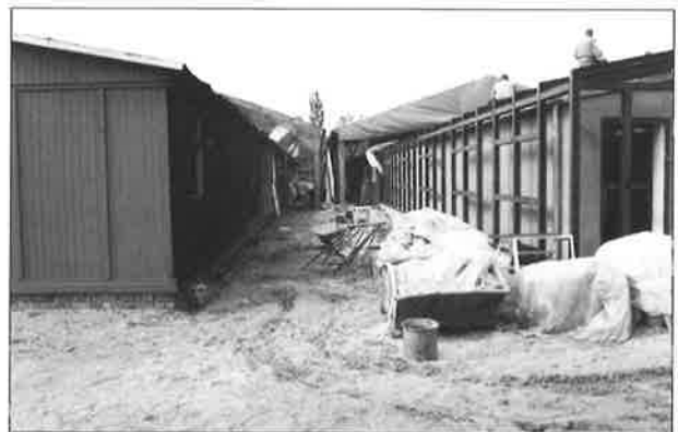
Bauarbeiten an den Baracken 38 und 39
