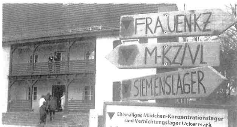
Für die internationale Jugendbegegnungsstätte am ehemaligen Frauen-KZ Ravensbrück wurden Häuser der SS-Aufseherinnen rekonstruiert und umgebaut.
